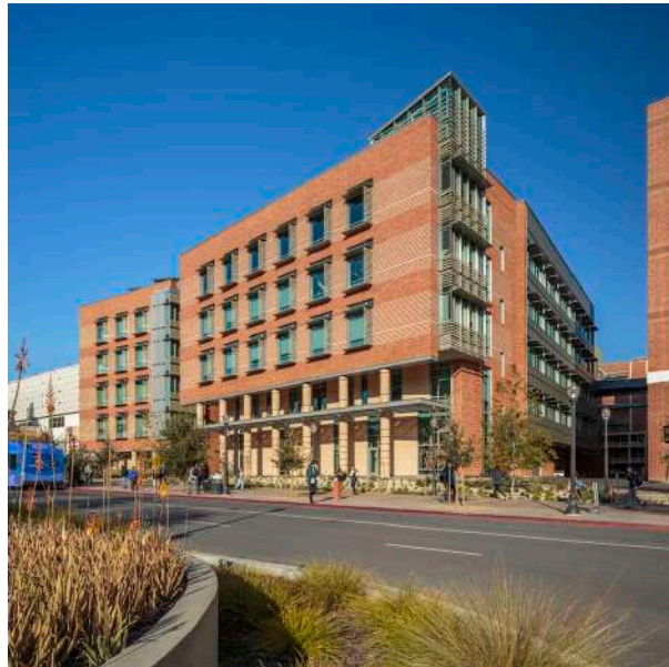
図2 UCLA 工学部の建物の一つ。中には二進数で表記された扉もあります。
